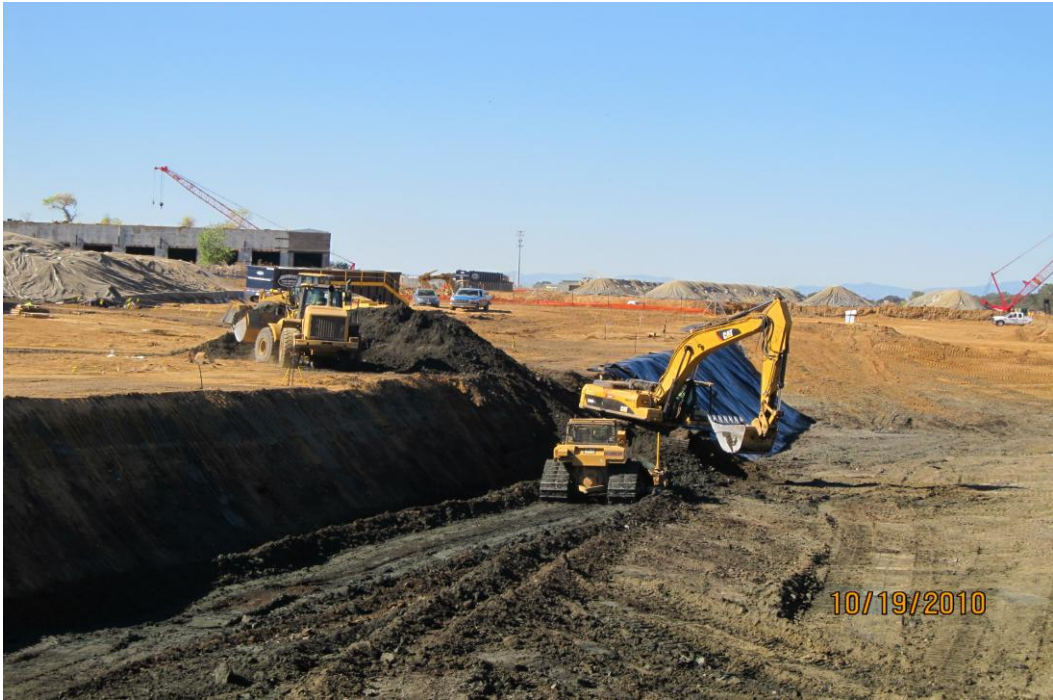
PACTIV Landfill Excavation
