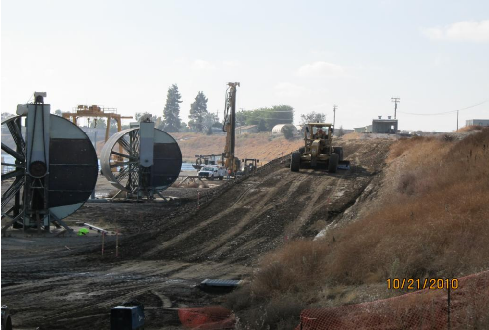
Access Ramp Earth Fill
