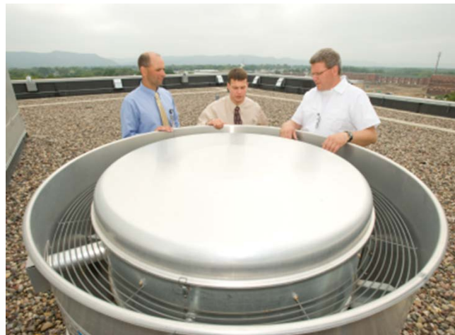
Exhaust Fan Motors
