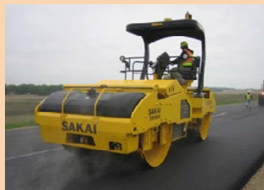
Sakai asphalt IC roller
