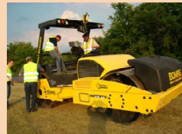
Bomag asphalt IC roller
