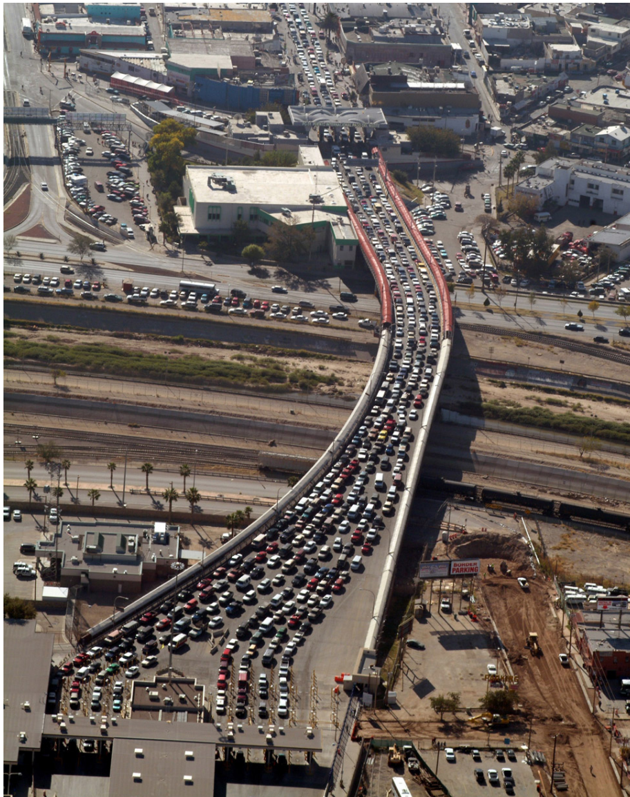
Figure 26: El Paso Street Bridge (Downtown El Paso, Texas)
