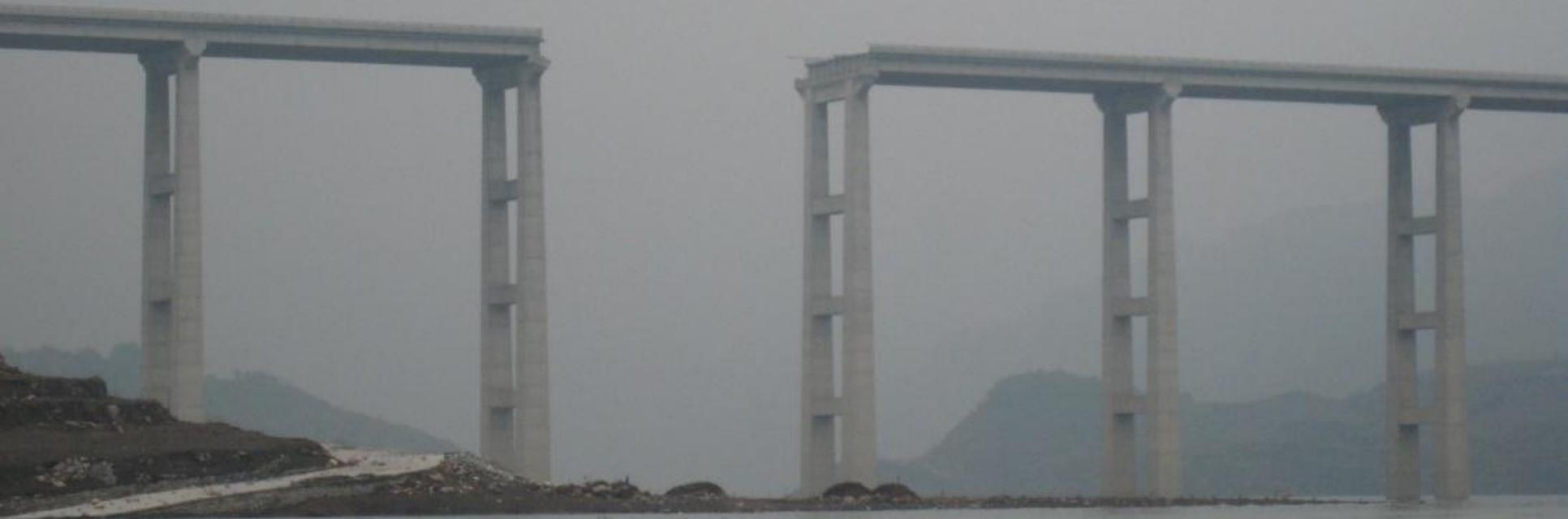
引桥为跨径50m简支T梁，桥面连续结构，高桥墩为双柱式排架墩，其中一联的边跨在地震中整体落梁。
