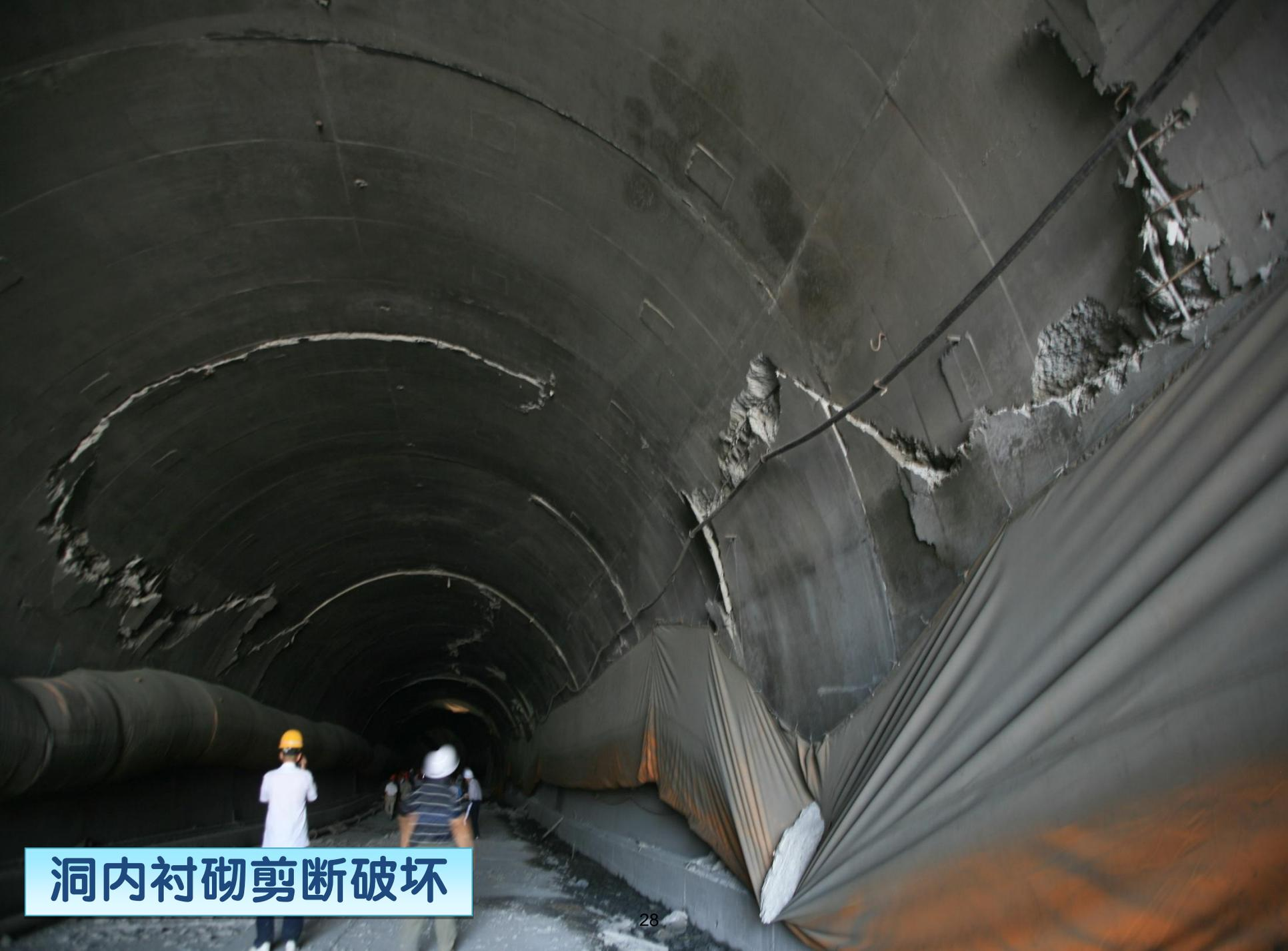
洞内衬砌剪断破坏
