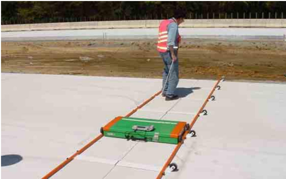
Figure 2. Scanning a joint using MIT Scan-2.
