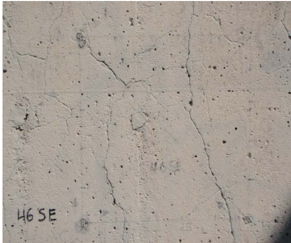
A – Column 46 SE Face 2009
