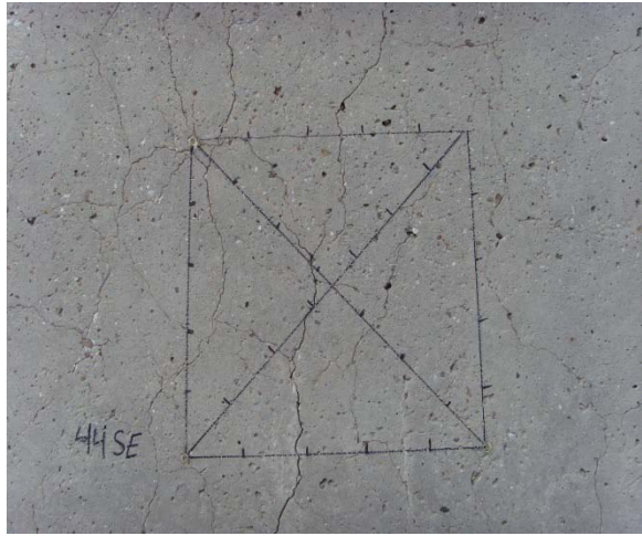
B – Column 44 SE Face 2011
