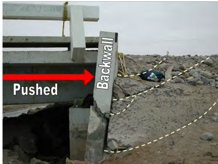
Figure 12-7 Puente Los Banos Bridge
