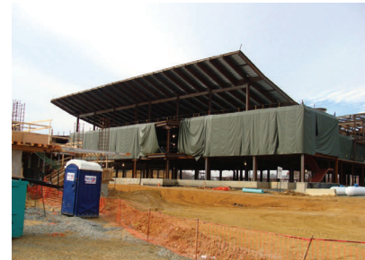
D Building Floor Pour
