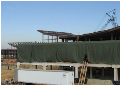
D Building Floor Pour
