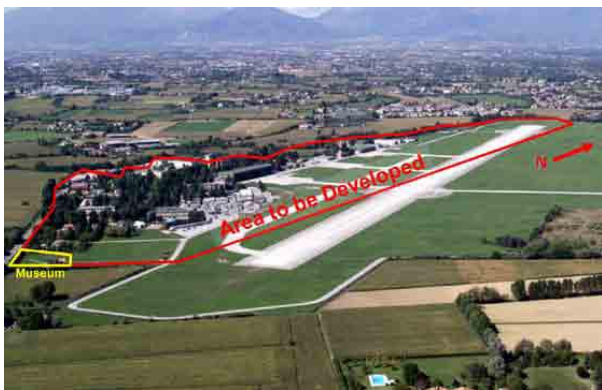
Figure 6: Dal Molin Site
