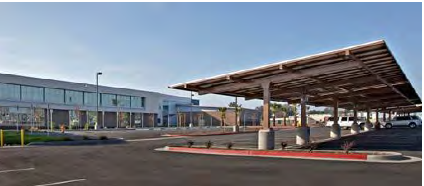
Los Alamitos PV Array
