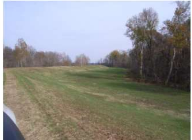
Levee Item 9A-1
