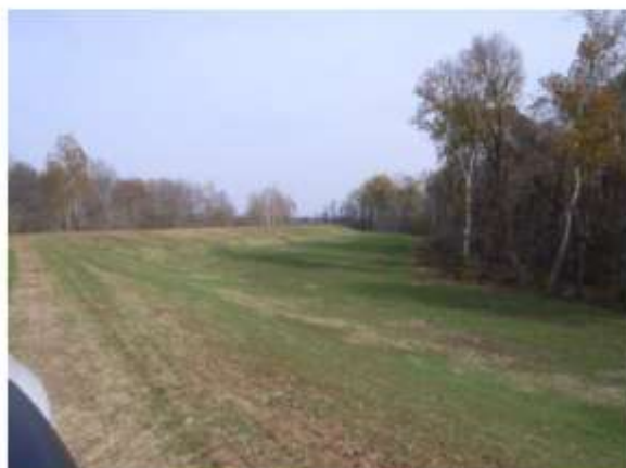
Levee Item 9A-I
