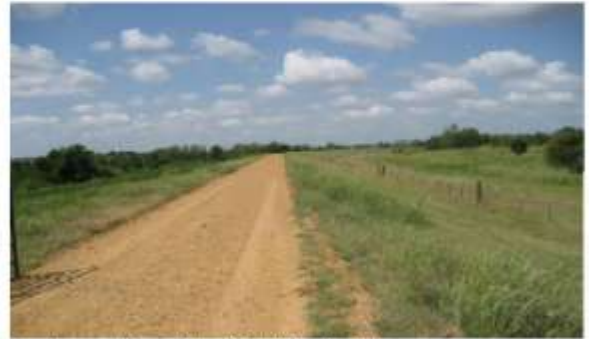
Ascalmore-Tippo Sta. 335+00 – North Levee
