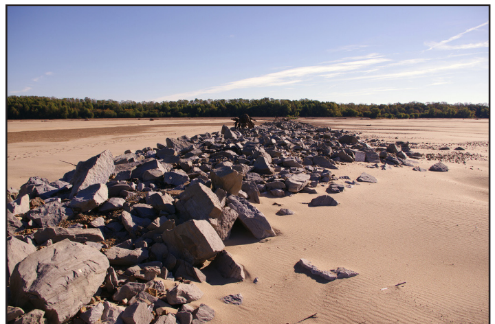
An existing dike.
