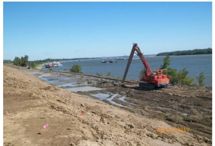
Cairo, IL Slurry Trench and Berm Parcel 5
