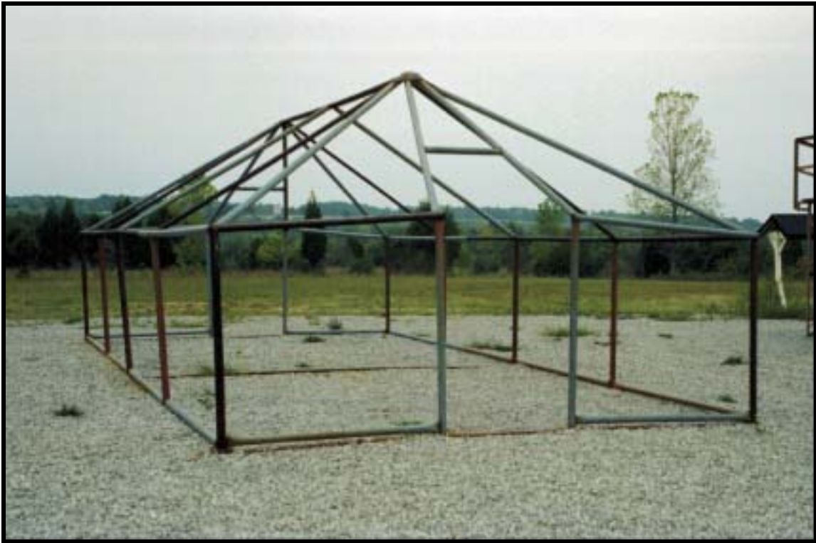
Figure 4.1.231 Metal tent frame, Ft. Knox, view NE (RCG&A).
