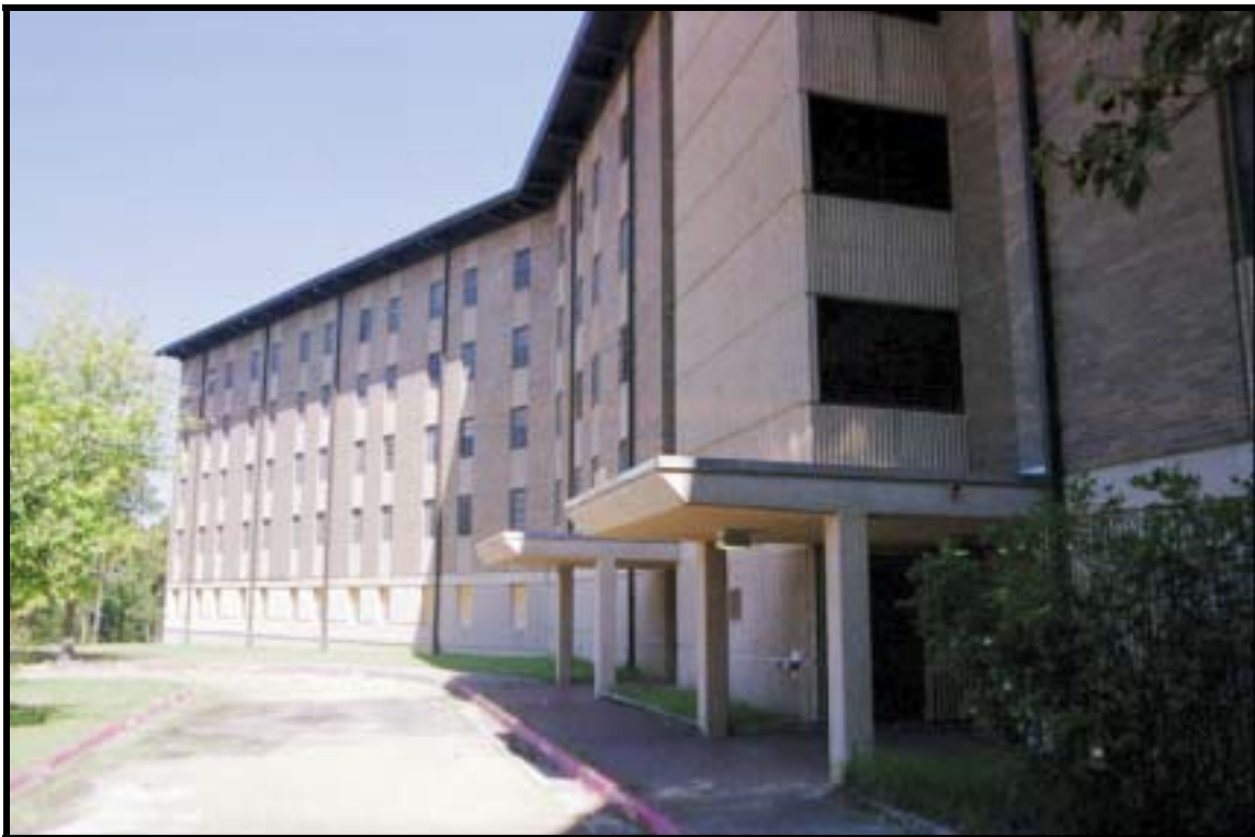
Figure 4.2.77 High Rise BOQ, Woodfill Hall, Bldg. 350 (1979), Ft. Polk, view NE (RCG&A).
