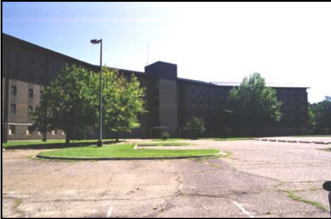
Figure 4.2.78 High Rise BOQ, Woodfill Hall, Bldg. 350 (1979), Ft. Polk, view SE (RCG&A).
