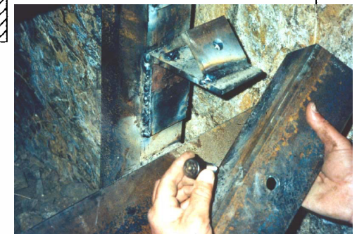
LOCK TAB DETAIL N.T.S.
