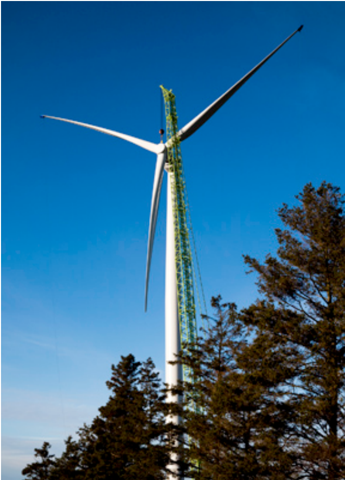
Siemens 3.0 MW turbine
