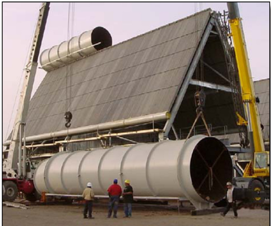
An Actual SPX Air Cooled Condenser Module
