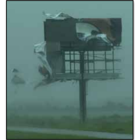
Arriba: Daños causados a una cartelera publicitaria durante el Huracán Lili en octubre de 2002.
