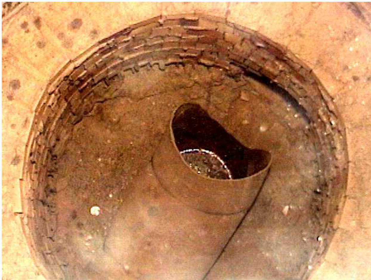
Figure 5-3. PFP Z8 Manhole
