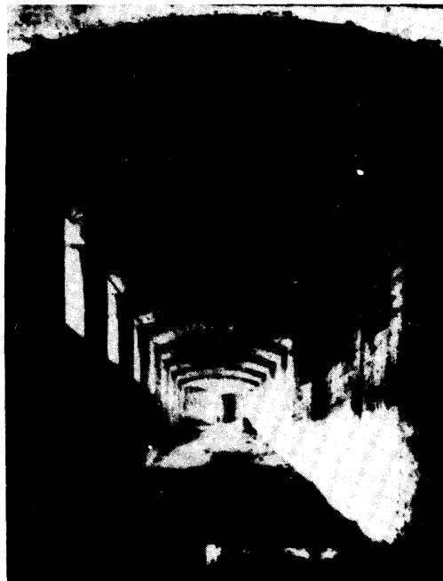
The Longitudinal Culvert
