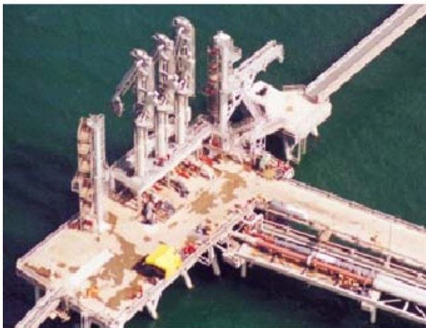
Figure 22. LNG Jetty with Unloading Arms - ALNG
