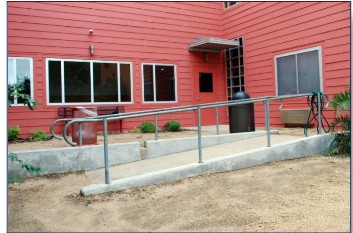
Rampas de acceso a los patios del refugio de emergencia
