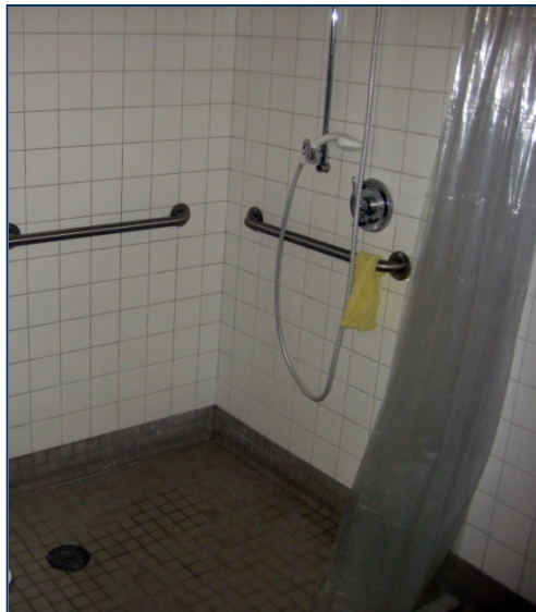
Ducha con acceso para sillas de ruedas con agarraderas y ducha de mano
