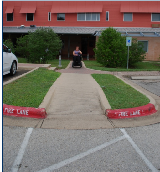
Camino accesible del refugio de emergencia
