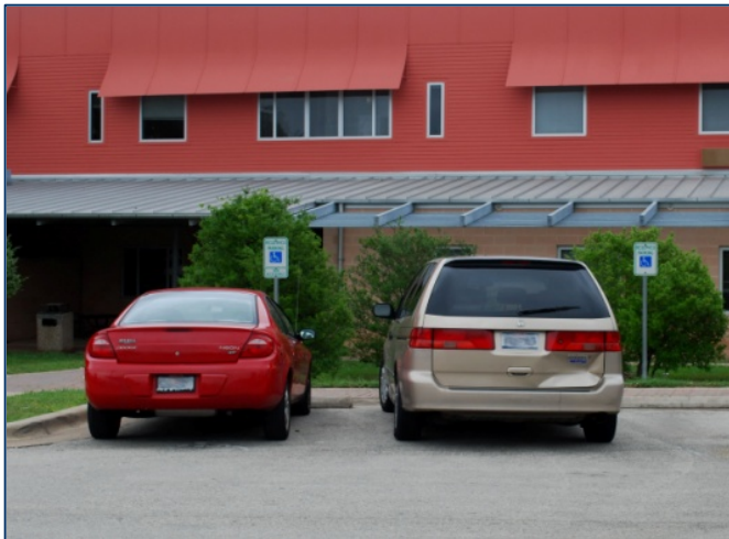
Estacionamiento accesible en el refugio de emergencia
