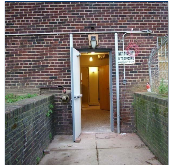
Nueva entrada principal
