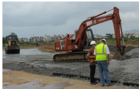
Mang vật liệu lấp sạch vào công trường (Ảnh: CDM Smith)
