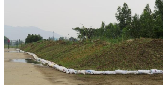
Bãi tập kết chứa khoảng 250 m 3 chất liệu đất mặt sạch, đang được ủ làm phân hữu cơ (Ảnh: CDM Smith)
