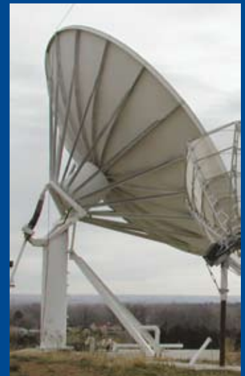
The 7-meter antenna.
