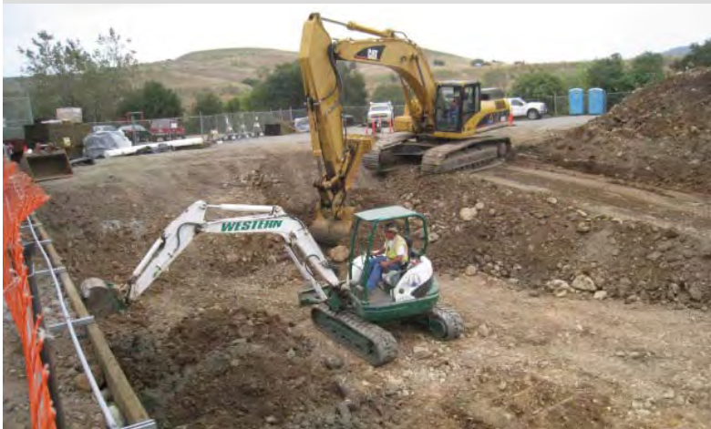
Mini –Excavator to get close to shoring
