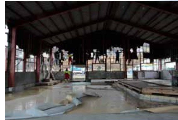
3月6日、岩国基地ボランティアはお土産屋兼食堂の解体作業を行った。 MCAS Iwakuni volunteers tear down a local souvenir shop and restaurant March 6, 2012.
