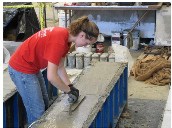
(d) Concrete finishing
