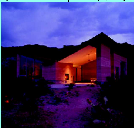
Casa de Montanha de Tucson, com paredes de terra prensada, projetada por Rick Joy
