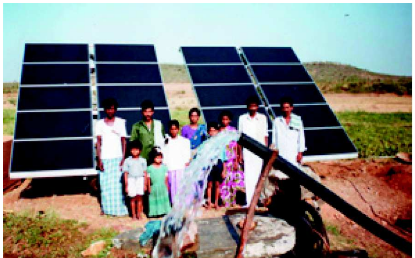
Bomba de energia solar na Índia, instalada como parte do projeto da Agência de Desenvolvimento de Energia Renovável da Índia
