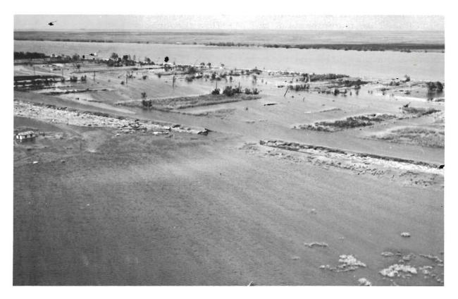
CAMILLE'S RELENTLESS SURGE ERODED GAPING HOLES IN THE BACK LEVEES IN PLAQUEMINES PARISH ...
