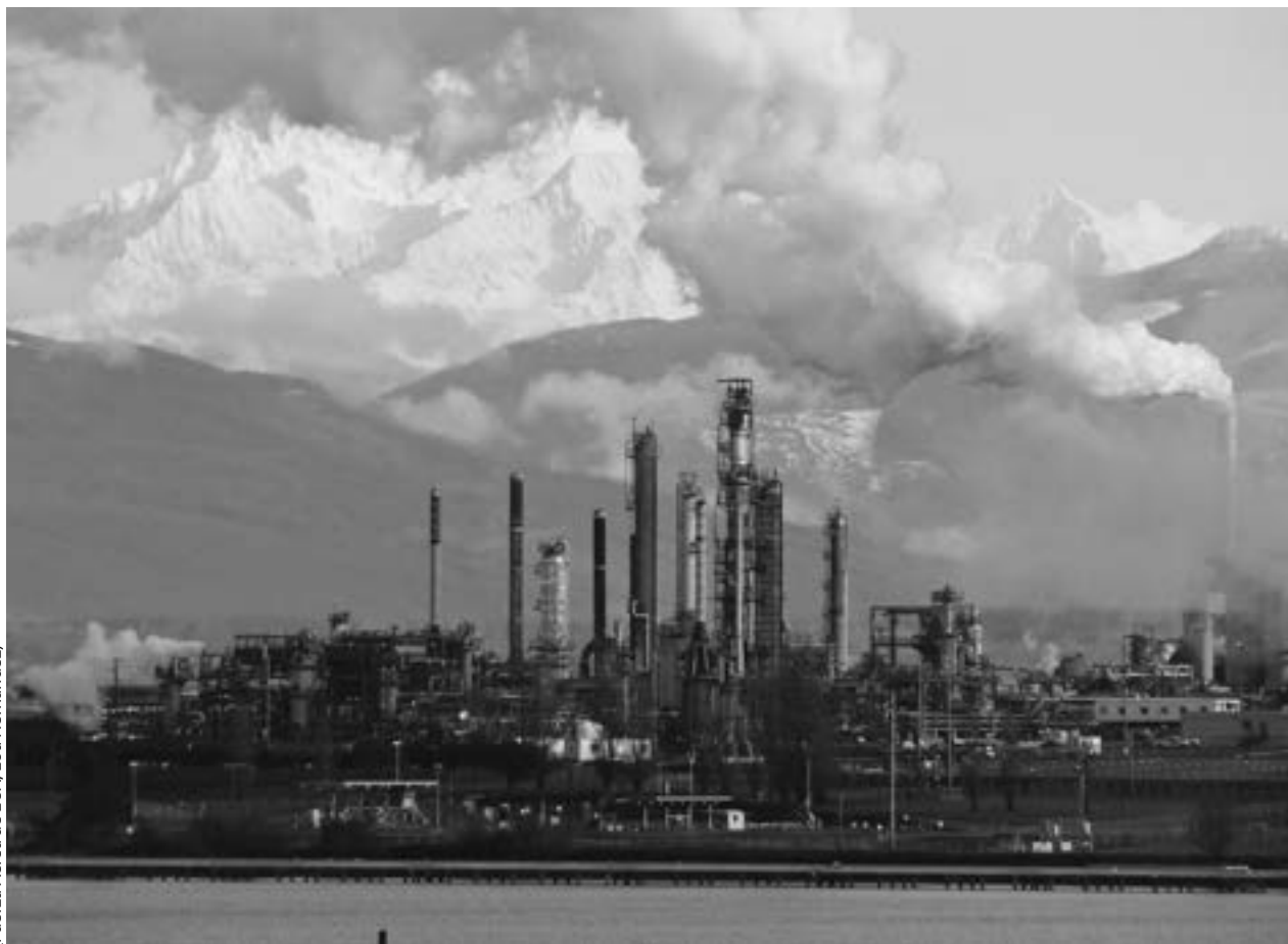
Refinería de Petróleo Anacortes, en las faldas de la montaña Baker, estado de Washington.
