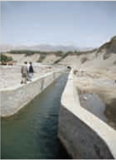
Travaux de réfection d'un canal d'irrigation (province de Kaboul) dans le cadre d'un projet financé par la Banque mondiale. (© Banque mondiale 2008)
