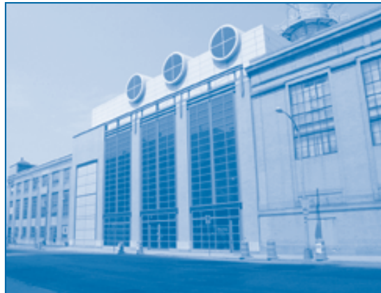
MIT Cogen Facility
