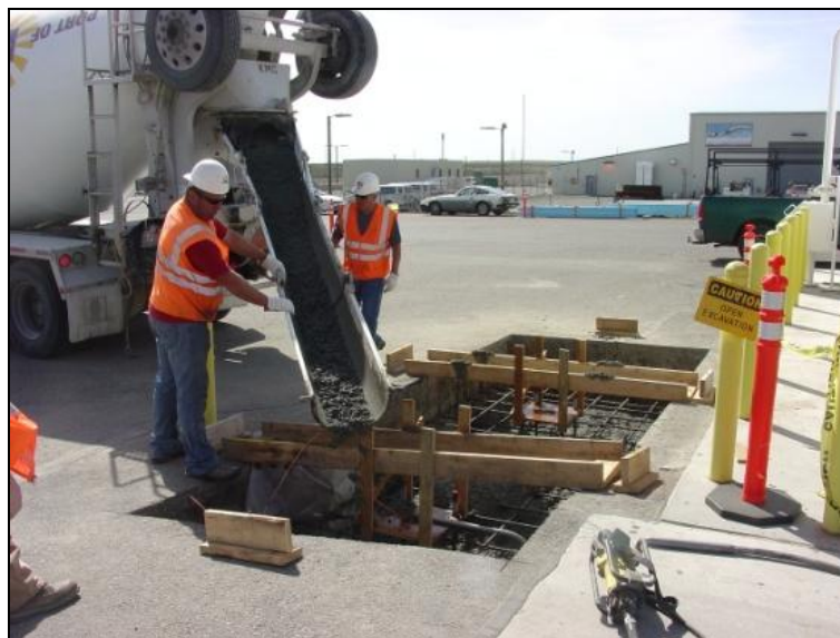
Concrete pour for Project L-659, 200E Fueling Station Renovations
