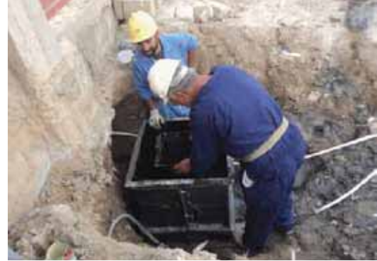
عمال يقومون بربط الأنابيب بخطاف لأعلى المنازل السكنية إلى نظام معالج المياه التالفة في الفالوجة بالبصرة، (صورة فيلق المهندسين بالجيش الأمريكي)
