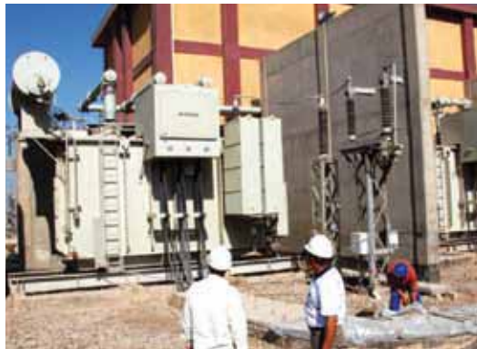
أكمل فيلق المهندسين بالجيش الأمريكي إنشاء محطة الفارابي 33-132 kv كيلو فولت في مدينة الصدر في شباط/فبراير وقامت بتسليمها إلى وزارة الكهرباء. (صورة فيلق المهندسين بالجيش الأمريكي)
