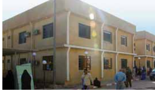
وتتضمن تحسينات محكمة مدينة الصدر التي يمولها الولايات المتحدة الأمريكية. نوافذ مضادة للرصاص والشظايا بالإضافة إلى اضاءة سلامة جديدة. (صورة فيلق المهندسين بالجيش الأمريكي)
