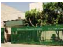
Aspecto del edificio de la Biblioteca en la calle de Liverpool (2012)
