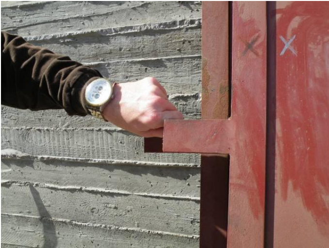
Site Photo 11. Embedment tab
