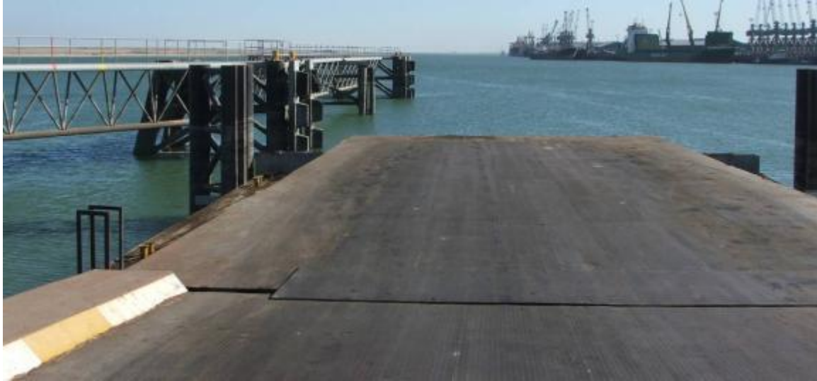
Site Photo 14. Empty RORO Berth 22
