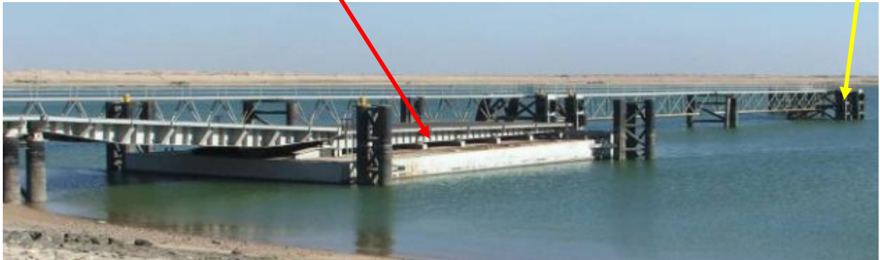
Site Photo 10. Umm Qasr RORO Berth 22
