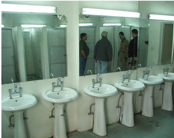
Site Photo 23. Restroom washbasins
