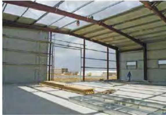
مرآب صيانة السيارات قبل إكمال تركيب الألواح الخارجية في الكسيك
