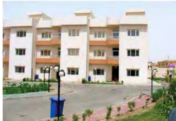
منظر خارجي للمبنى السكني للصبيان
