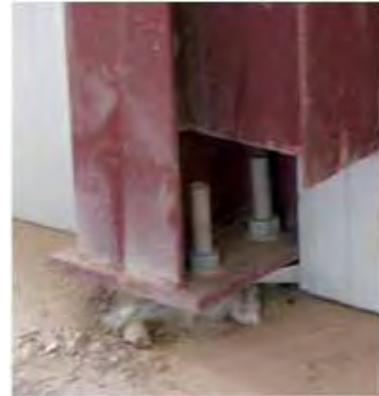
لوحة قاعدة لعمود قبل وضع ملاط عديم النقص لحقن الفراغات في الكسيك.
