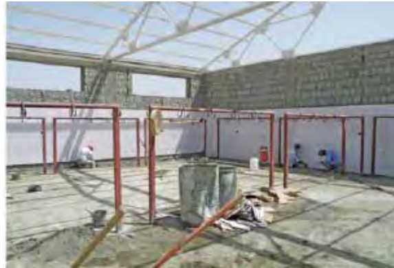
منظر داخلي لغرفة المسلخ
