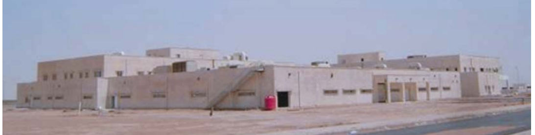
بنوع مكتب الشراكة الإستراتيجية في العراق (ISPO) الآن إتمام الأعمال الممولة من الولايات المتحدة في مستشفى ميسان الجراحية في أكتوبر/تشرين الأول 2012. تم منح عقد الإنشاء في البداية في شهر سبتمبر/أيلول 2007، وكان تاريخ الإتمام الأصلي مايو/أيار 2009. (صورة من USACE)
