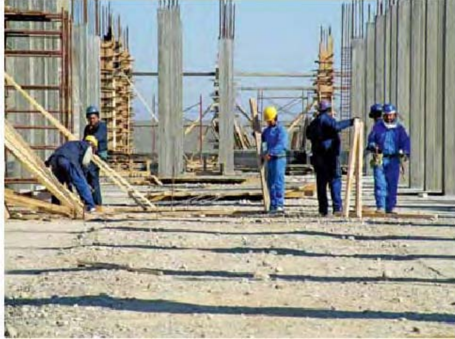
أعمال الإنشاء الجارية في مستشفى ميسان الجراحي
