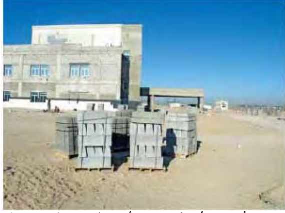
حجارة الأرضية وأشغال تسوية الأرض لمواقف السيارات الخارجية في مستشفى البصرة للأطفال
