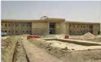
الغلاف الاسمنتي لمبنى المحكمة في الحلة الجديدة في محافظة بابل. (صورة لسلاح الهندسة في الجيش الأميركي USACE)
