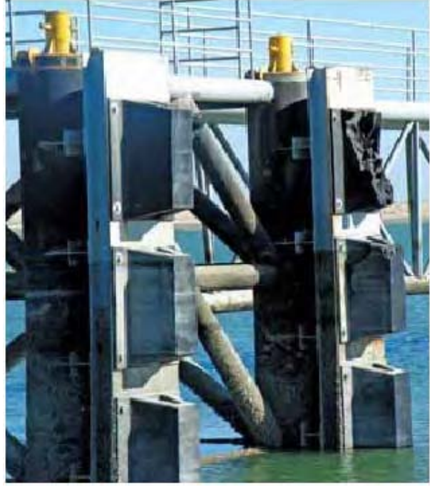
رصيف التحميل والتفريغ ٢٢ يعاني من المصدات المطاطية
