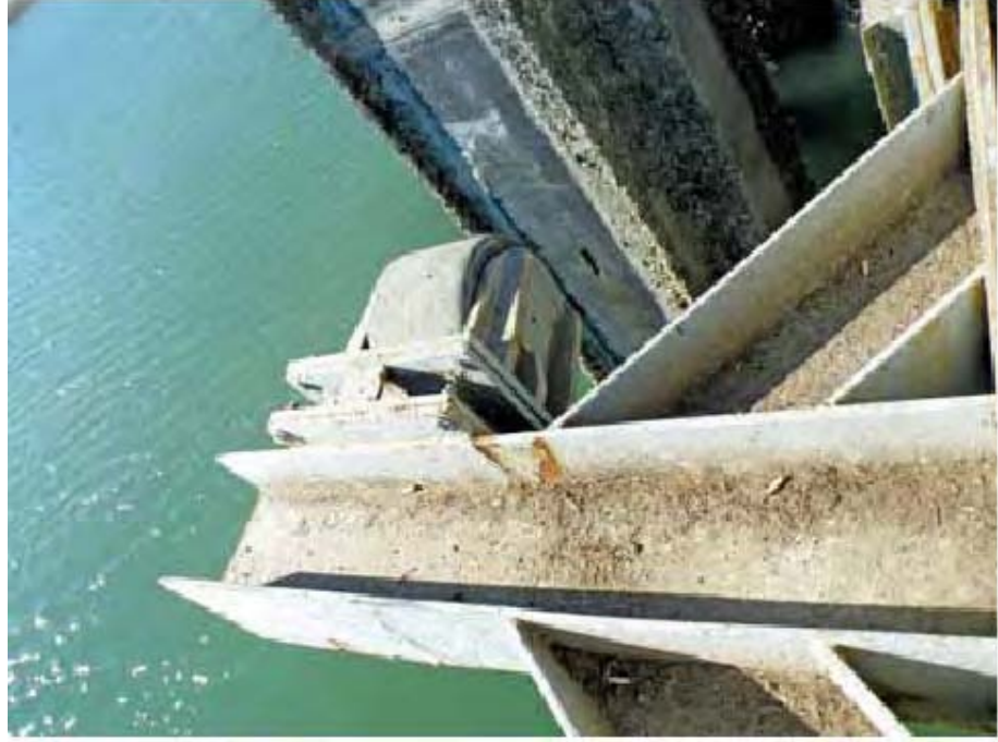
دلافين إسناد مع ألواح مباحدة فولاذية لرصيف التحميل والتفريغ
