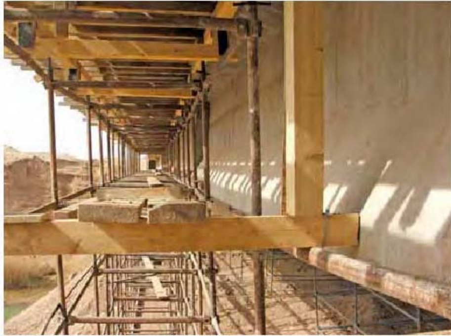
الأشغال الخاطئة لتشكيل خرسانة السطح تتدلى في جسر المجرّة
