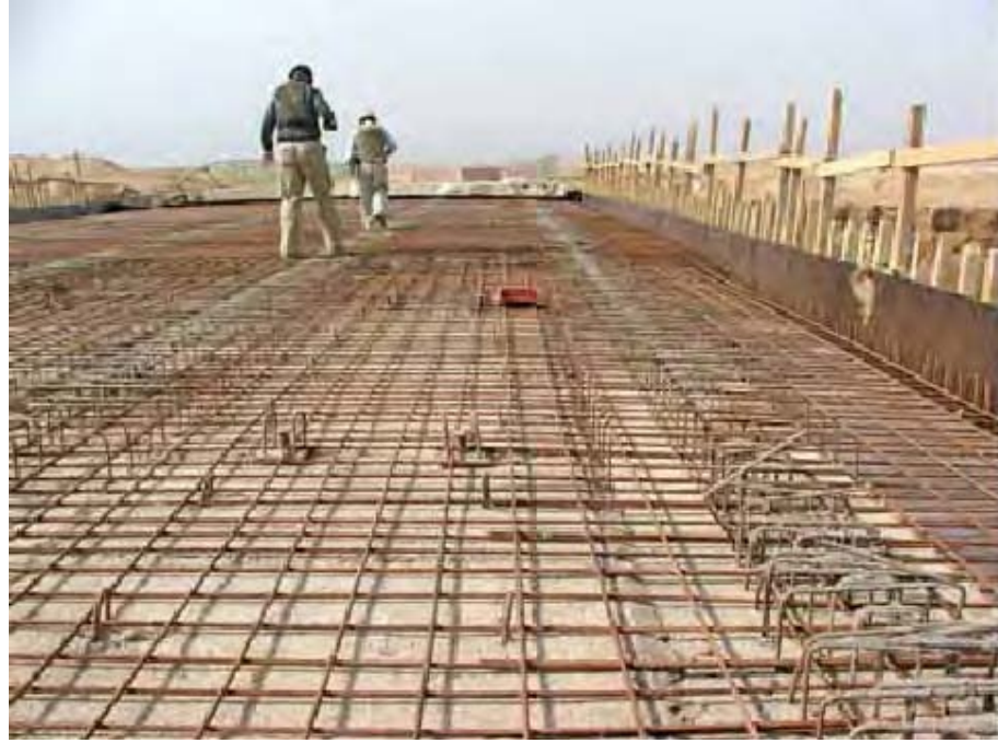
تسليح السطح الخرساني (قبيل وضع الحصيصة فوقية)
