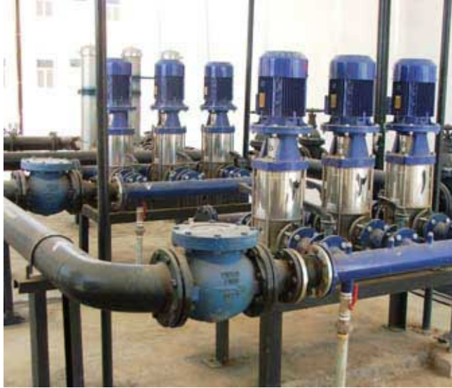
مجموعتان من مضخات تعزيز تدوير المياه الصالحة لشرب عبر كامل مرافق الحامية
