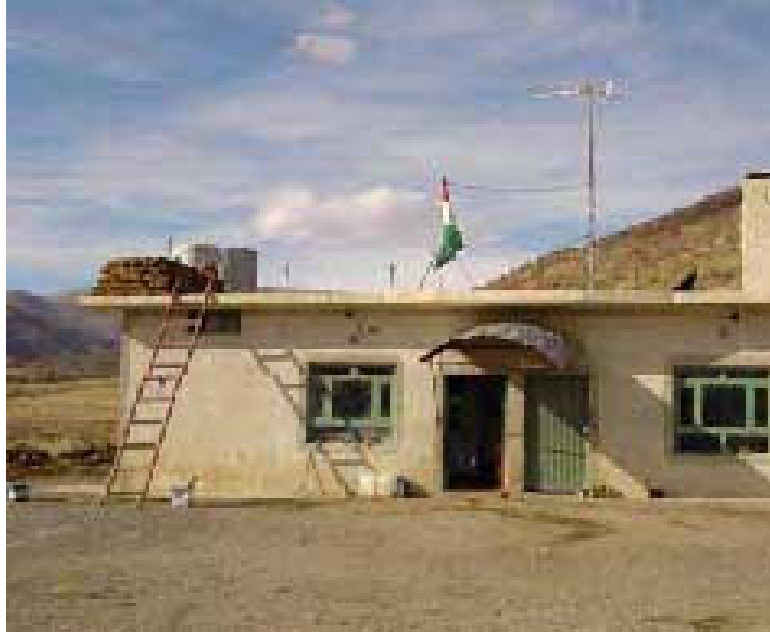
الواجهة الخارجية لمخفر حدودي
