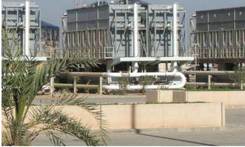
ثلاثة أزواج من أبراج التبريد لنظام التدفئة والتهوية وتكييف الهواء لصالة الركاب الرئيسية
