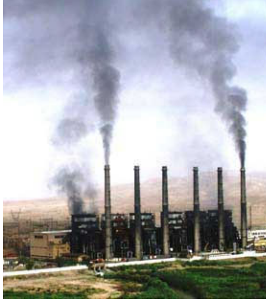
محطة توليد الطاقة الكهربائية في بايجي
