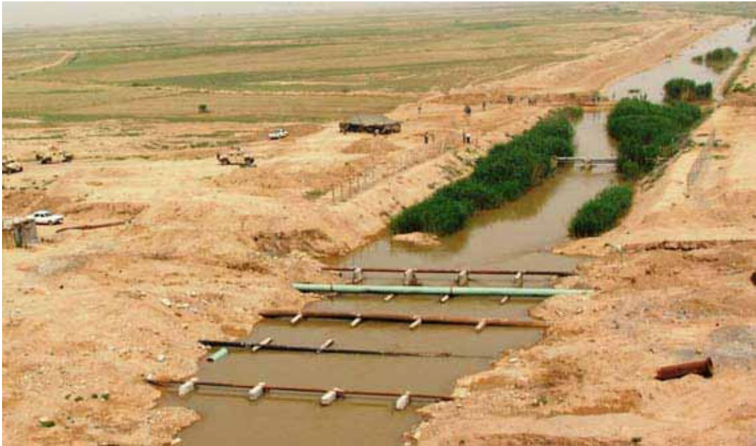
منظر جوي لمعبر قناة زيغينون (تظهر بوضوح خطوط الأنابيب القديمة)
