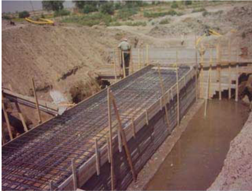
إنشاء مجرى سفلي ذو منفذ مستطيل (زود الصورة سلاح الهندسة في الجيش الأميركي)
