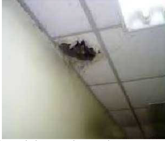
تلف في السقف سببته تسربات المياه في المستشفى التعليمي (المرحلة الأولى)
