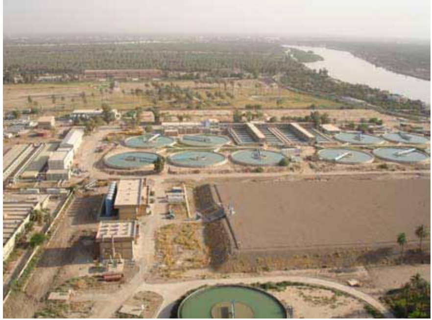
محطة معالجة مياه شرق دجلة، ثاني أكبر محطة في بغداد
