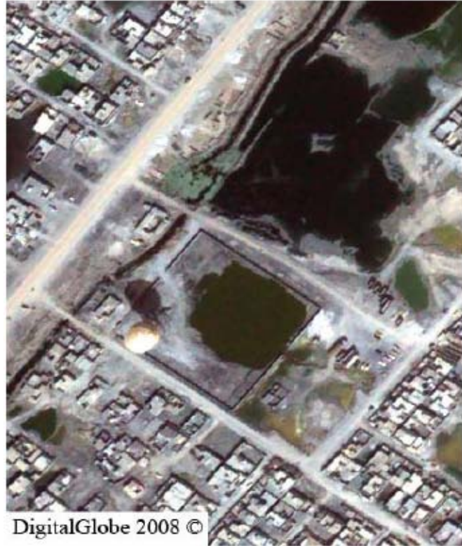
صور التقطت في ٢٨ شباط/فبراير ٢٠٠٨، لمحطة سوق الشيوخ، جزء من شبكة محطة معالجة مياه الصرف الصحي في الناصرية التي قيّمها المفتش العام في تقريره PA-07-116
