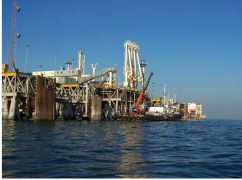
محطة البصرة لتحميل النفط (ABOT)
