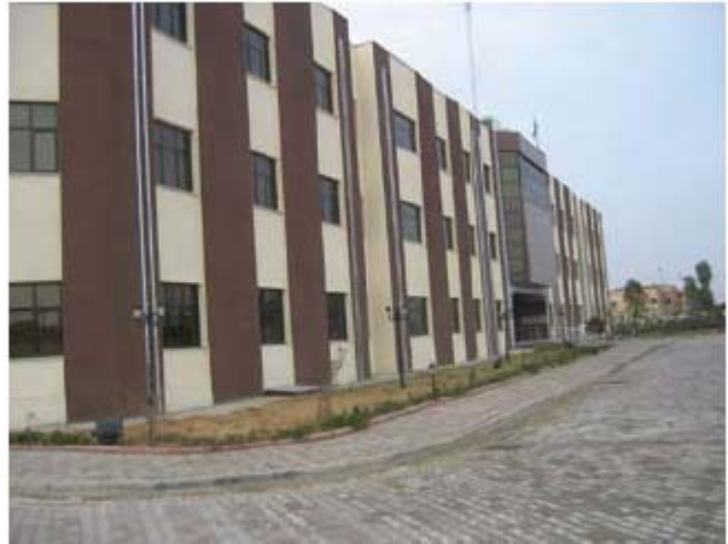
مبنى الخدمات بعد إعادة تجديده
