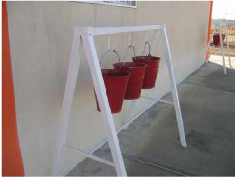
حاملات الدلاء لمعدات إطفاء الحريق الوحيدة التي لوحظت وقت زيارة الموقع
