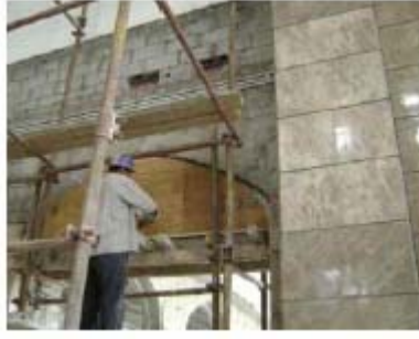
أعمال الكسوة بالحجارة للمدخل الرئيسي، آذار/مارس ٢٠٠٨
