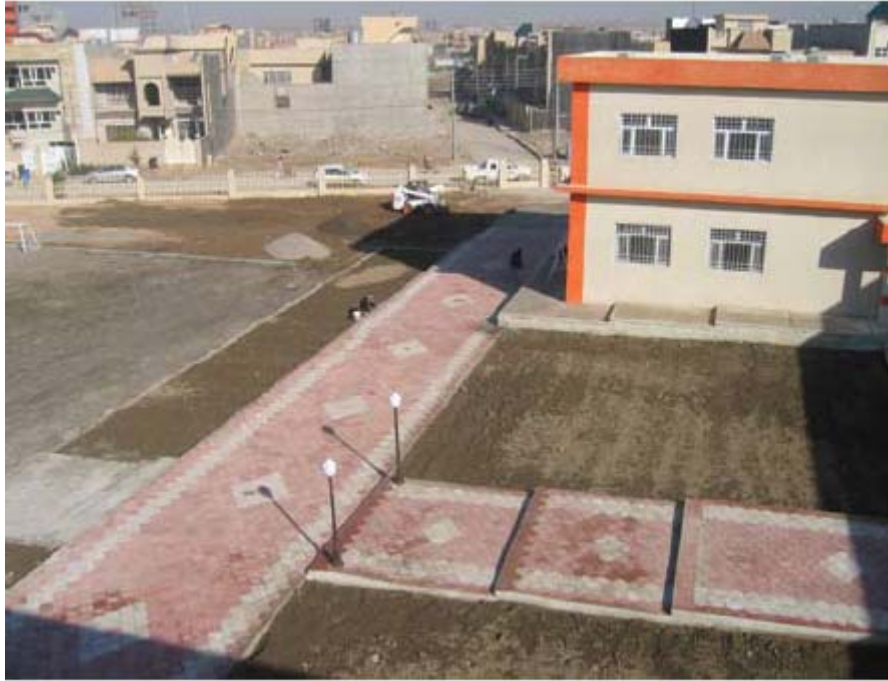
مدرسة سروران - تشطيب المبنى الخارجي
