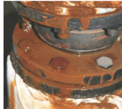
دليل عن تسرب المياه من خط المياه الساخنة
