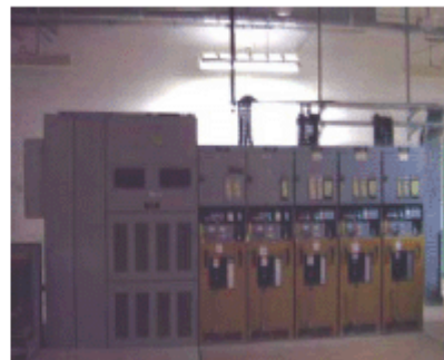
نظام توليد طاقة 11 كيلو فولت (الصورة مقدمة من الوكالة الأميركية للتنمية الدولية (USAID))
