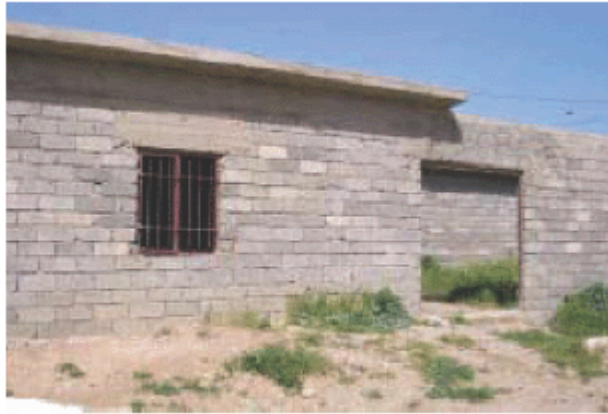
شملت أشغال تجديد الأرضية وبناء خلية سجن وتركيب قضبان فولاذية على النوافذ
