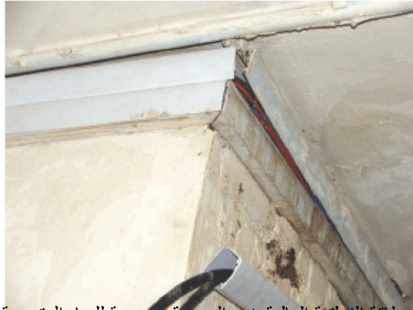
كبلات طاقة الفولتية العالية غير المحمية معرضة للمياه المتسربة
