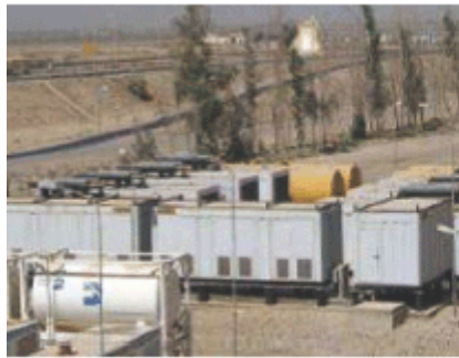
سبعة مولدات ماركة كاتربيلر، (الصورة مقدمة من الوكالة الأميركية للتنمية الدولية (USAID))
