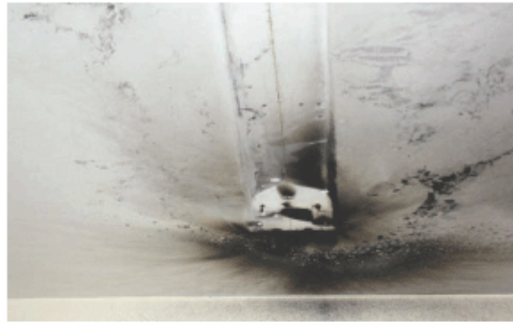
كبلات طاقة الفولتية العالية غير المحمية معرضة للمياه المتسربة
