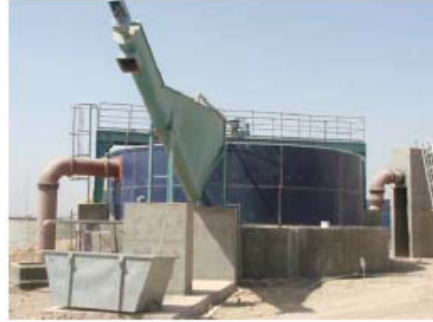
مشروع مياه الصرف الصحي في الفلوجة. خزان النفط والرمل وجهاز التصنيف
