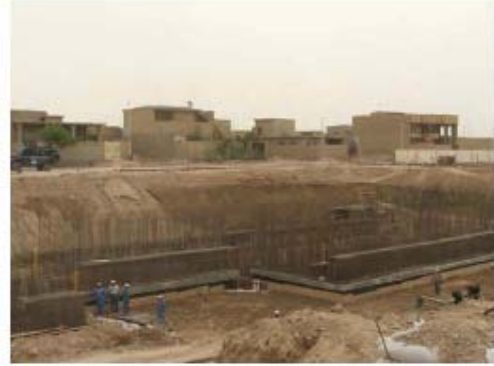
مشروع مياه الصرف الصحي في الفلوجة: إنشاء محطة مضخات الصبيب
