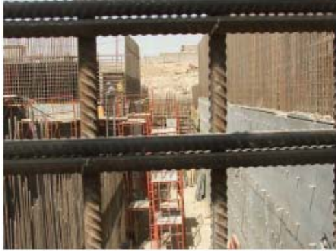
مشروع مياه الصرف الصحي في الفلوجة: إنشاء جدار حطة المضخات ف ١
