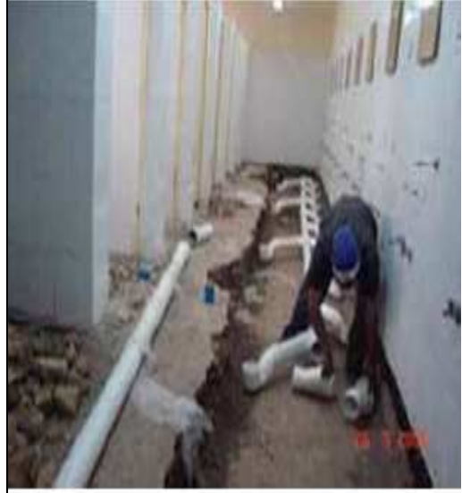
صورة الموقع 8 - كانت هناك حاجة لإعادة عمل وساعة في عنابر النوم لتركيب تركيبات أدوات صرف صحي محكمة ضد تسرب الماء (صورة من الهندسة والتقييد والبناء).
