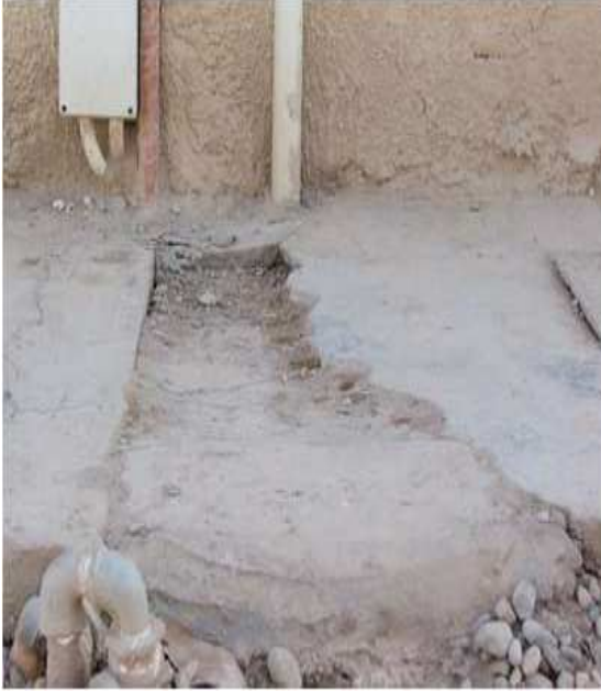
صورة الموقع 11 – تشطيبات دون المستوى في رصيف شارع بمقر الأكاديمية.
