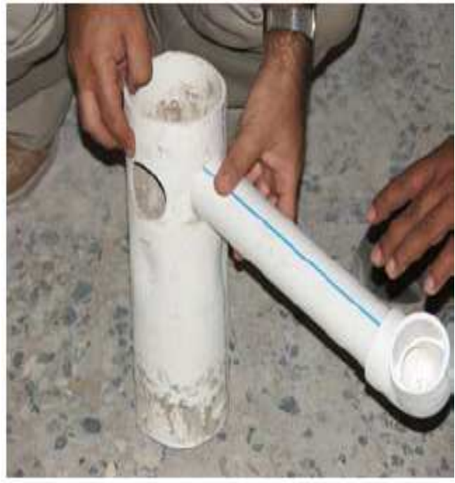
صورة الموقع 35 – أسلوب وصل أنابيب المياه العادمة التقليدية التي يتبعها المقاول.
