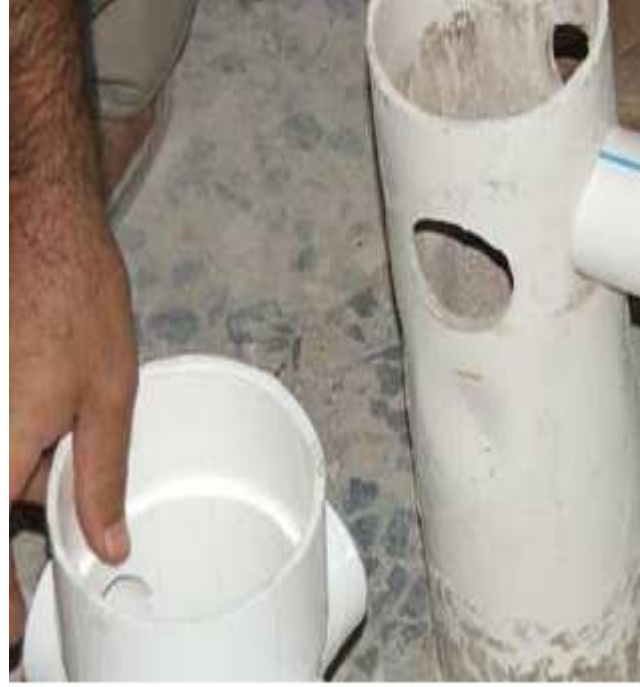
صورة الموقع 36 – وصلة أنبوب مياه عادمة حسب مواصفات المقاول تظهر في أسفل الصورة.
