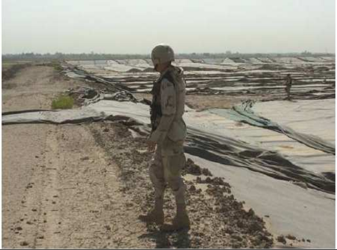
صورة الموقع 6 – جزء من الحاجز الضيق في المحيط يحتاج إلى عمل تصحيحي لدعم البطانة
