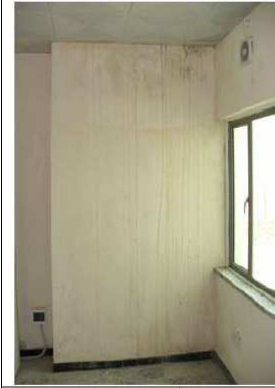
صورة الموقع 32 – أضرار في الجدار ناتجة عن تسرب المياه العادمة
