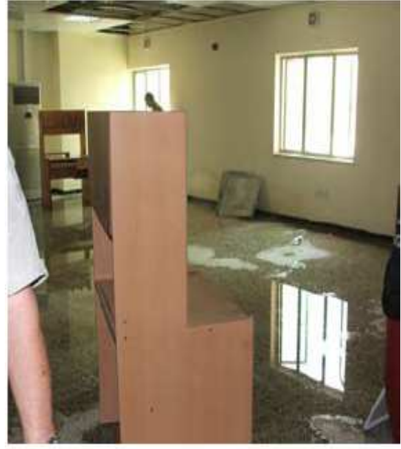
صورة الموقع 33 – أضرار المياه من التسرب من السقف.
