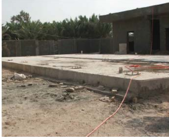
أساسات وحدة معالجة المياه المدمجة في الأجر
