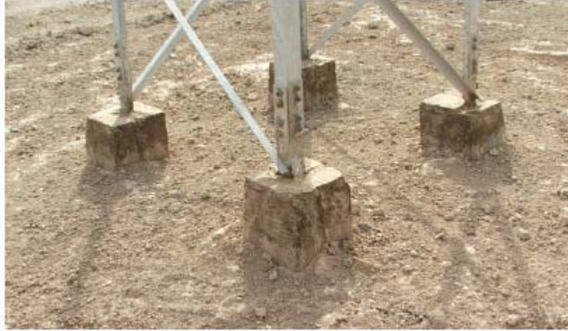
أساسات برج كهرباء ضمن مشروع خط الكهرباء
