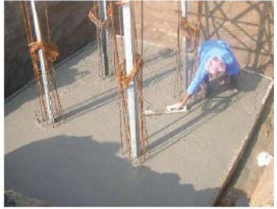
أعمال خرسانة نهائية في مشروع خط إمداد الكهرباء (صورة من سلاح الهندسة في الجيش الأميركي)
