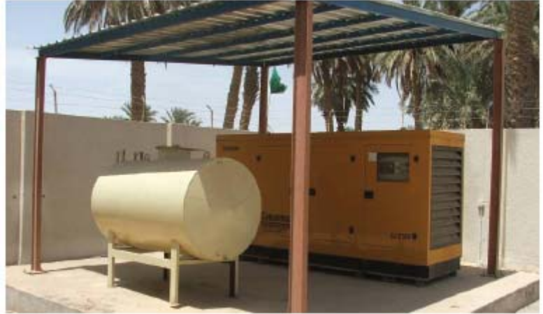
سقفية لمولد الكهرباء وخزان الوقود الخاص به في محطة معالجة مياه الشوفا
